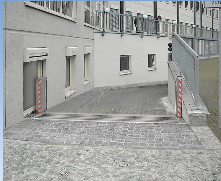
Klappschott geöffnet und geschlossen, Bild Fa. Anhamm
